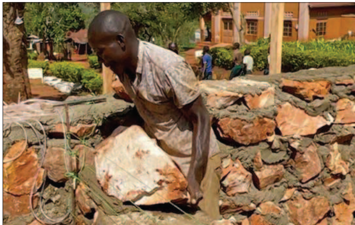
Der Bau des neuen Schulraums schreitet weiter voran.
